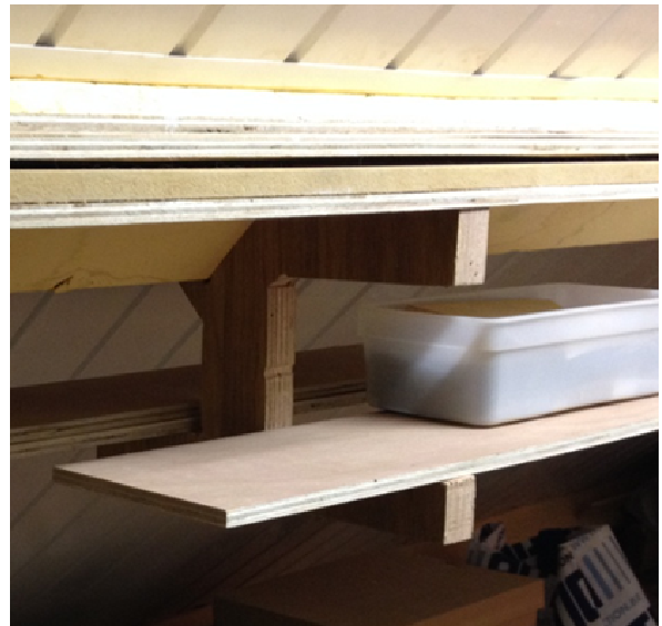
Gemonteerd frame voor de boven- en onderbaan.
