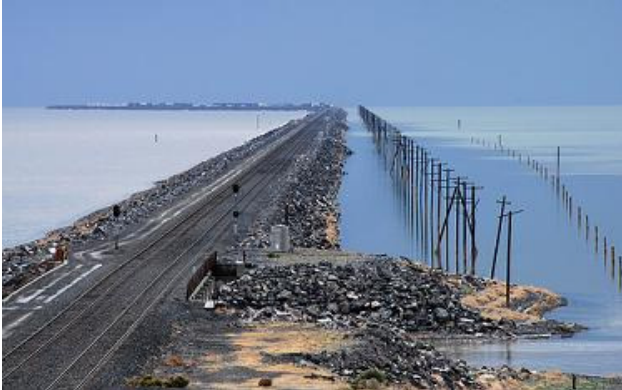
De huidige dam buigt verderop af naar links om vervolgens parallel te lopen aan de oude, inmiddels onttakelde, trestle.
