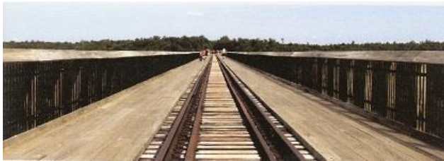
Het brugdek van de Kinzua bridge.
